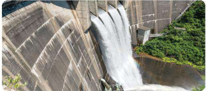
Đập nước của nhà máy thủy điện
