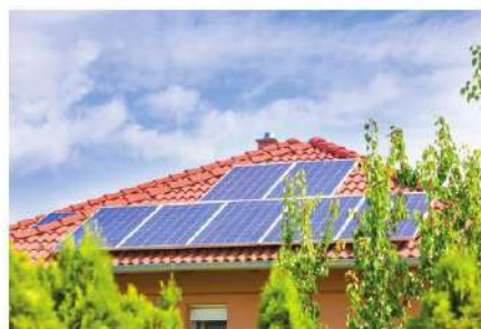
Hình 5. Nhà có sử dụng pin mặt trời
